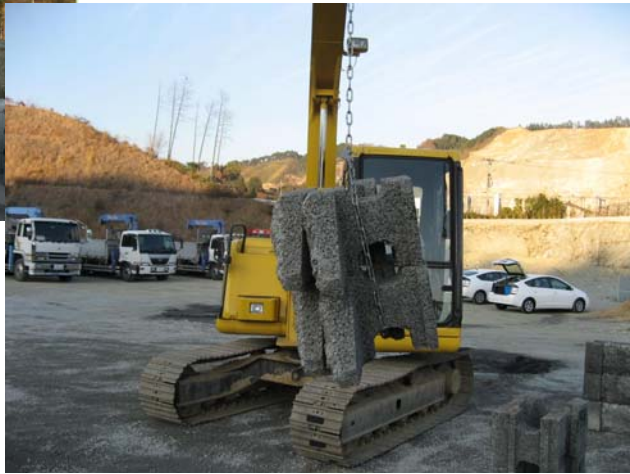
側石／天端石(C型)の 移動例です
