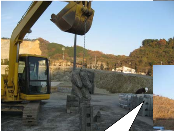
側石／天端石(C型)の 移動例です
