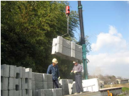
側石／天端石(C型)の 移動例です
